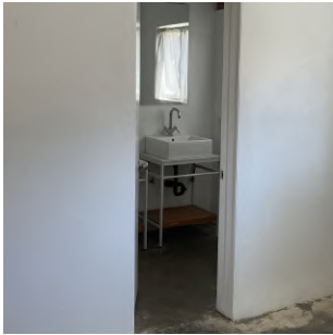
8. BATH ROOM DOOR
